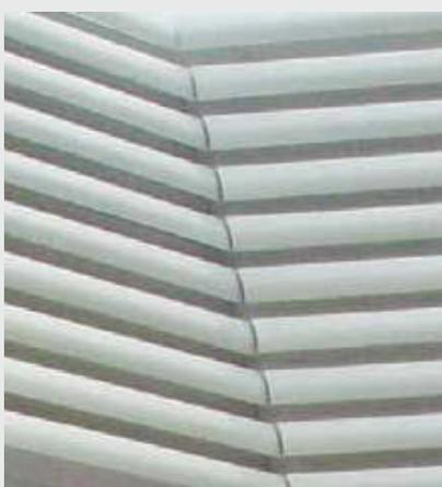
El panel Sunlines es una solución de control solar pasivo, el cual fue diseñado para utilizarse principalmente como cortasol cenital. Los paneles inferiores actúan como conductores del agua de lluvia, evitando que caiga directamente al piso. Produce una transmisión directa de la luz solar por efectos de la reflexión entre paneles superiores e inferiores, por lo que se recomienda el uso de colores claros.
